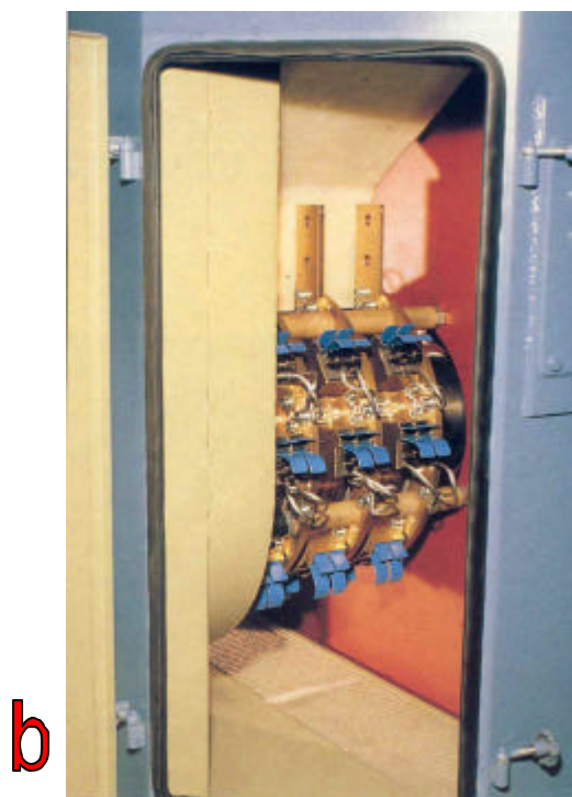
figuur 4.6 Sleepringrotor (a) en borsteldrager met sleepringen van een grote inductiemotor (b) (Foto ABB)
