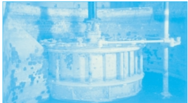
Foto 9: Francis-turbine, Watermolens, Harelbeke, 125 kW
