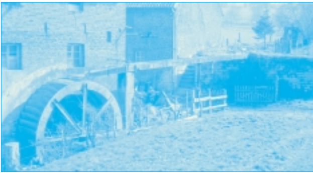
Foto 6: Bovenslagrad, Molen van Frissen, Sint-Martens-Voeren Bron: Paul Bauters
