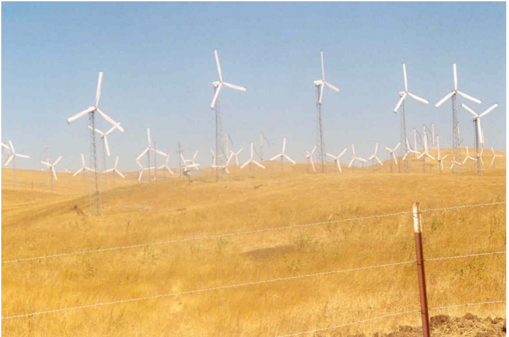
Windmolenpark in Altamont (Californië) met 100kVA generatoren
