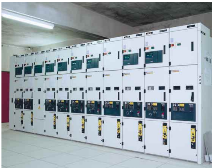
Cellules moyenne tension Merin Gerin MC 500.
